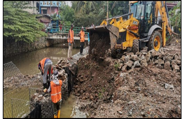
படோவிட்டக் கால்வாய் கேபியன் சுவர் பலப்படுத்தல் பணிகள்
