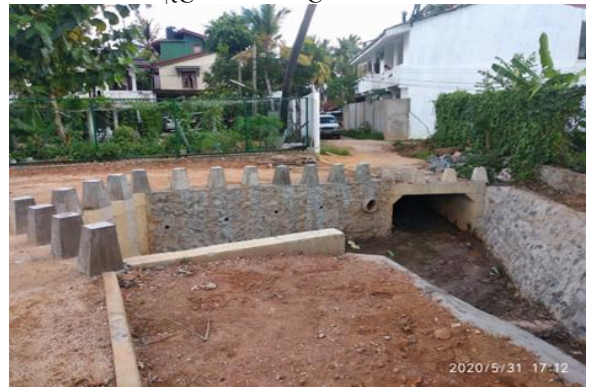
මානෙල් මාවත වැව මහජන පරිහරණයට ඉඩ සැලසෙන පරිදි වැඩ නිම කිරීමේ කාර්යයන්
